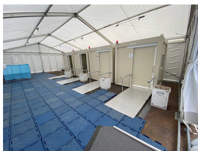
<仮設多目的トイレ>
