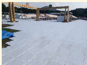
土・芝生面への下地養生敷設
