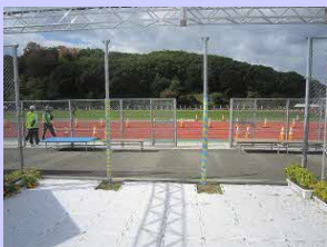
危険個所の養生
