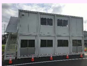
ユニットハウスの採用
