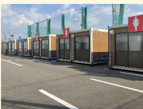
水洗トイレの整備
